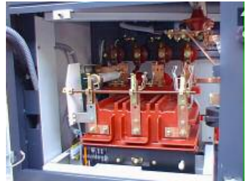
Chariot débrochable équipé d'un contacteur au SF 6
